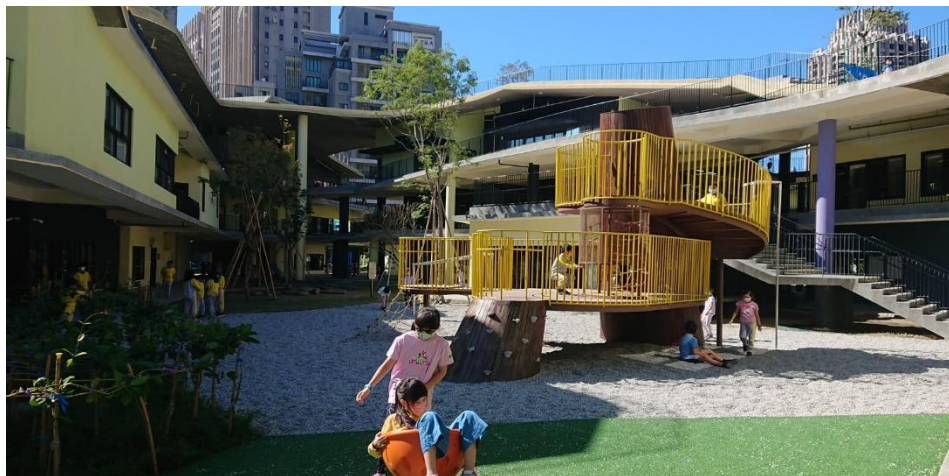
遊戲場安全認證/鋪面修補、重填圓礫石
