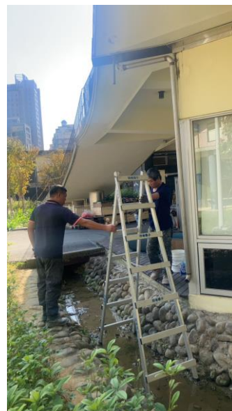
雨水管移設
