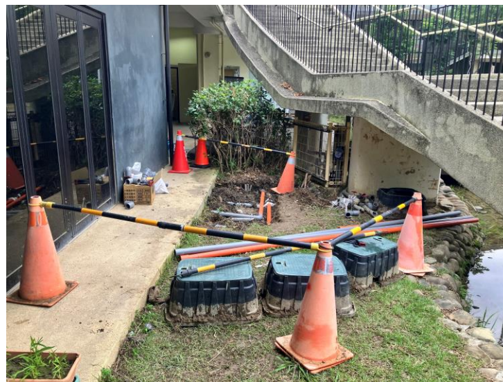
澆灌筏箱漏水改善
