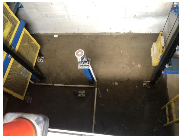
行政大樓電梯機坑漏水補強
