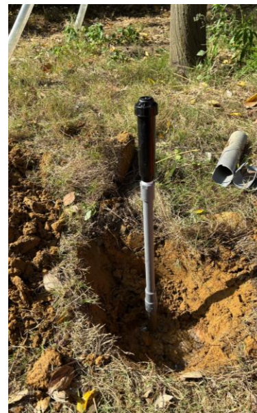
澆灌噴頭斷裂維修
