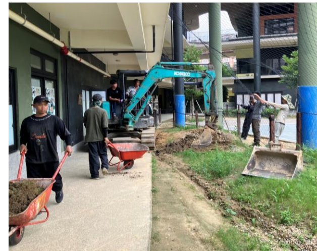
景觀排水管溝+蓋板
